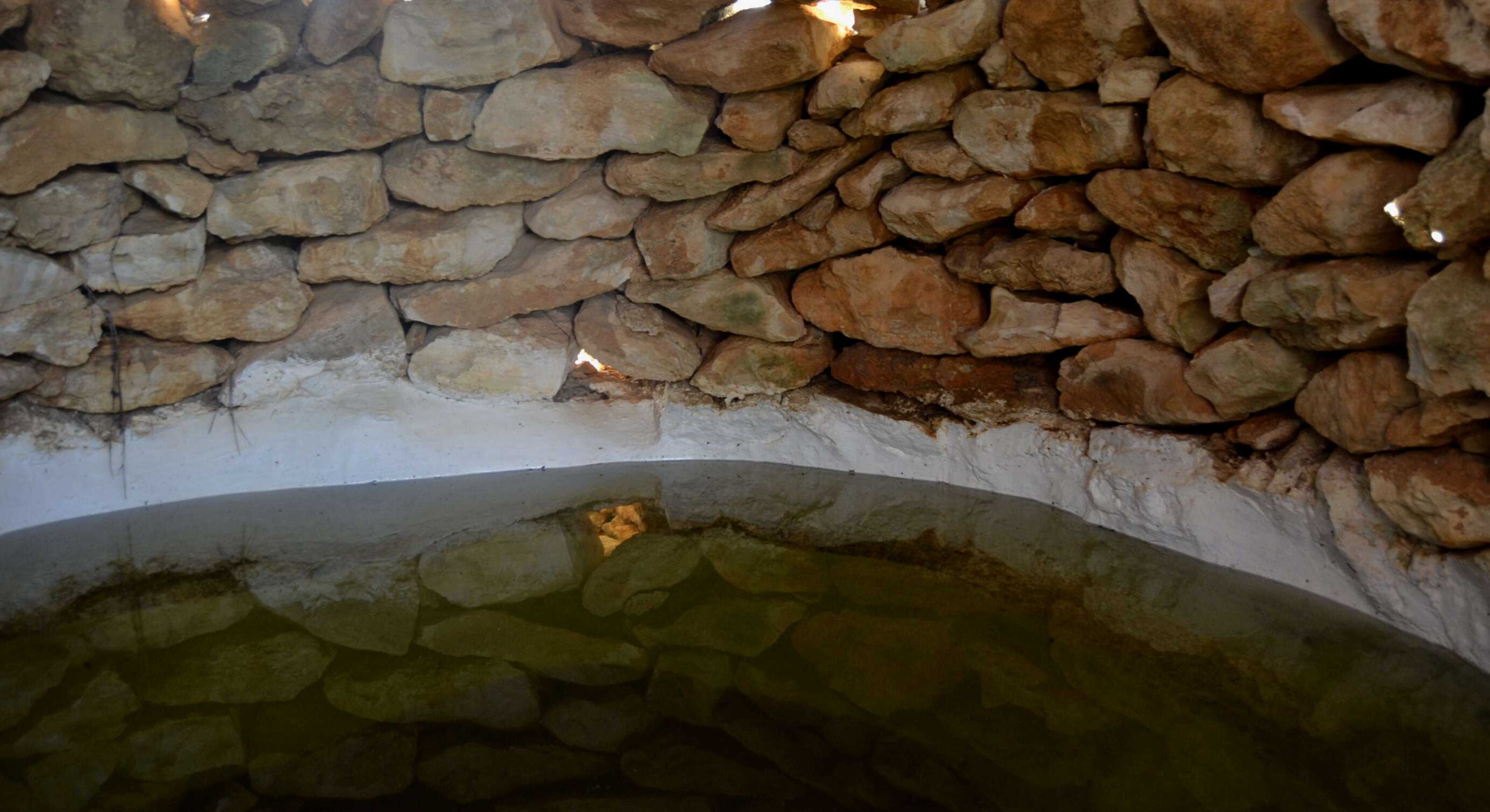
Interior d'un cocó ple d'aigua ubicat al terme municipal de Tivenys (Baix Ebre).
