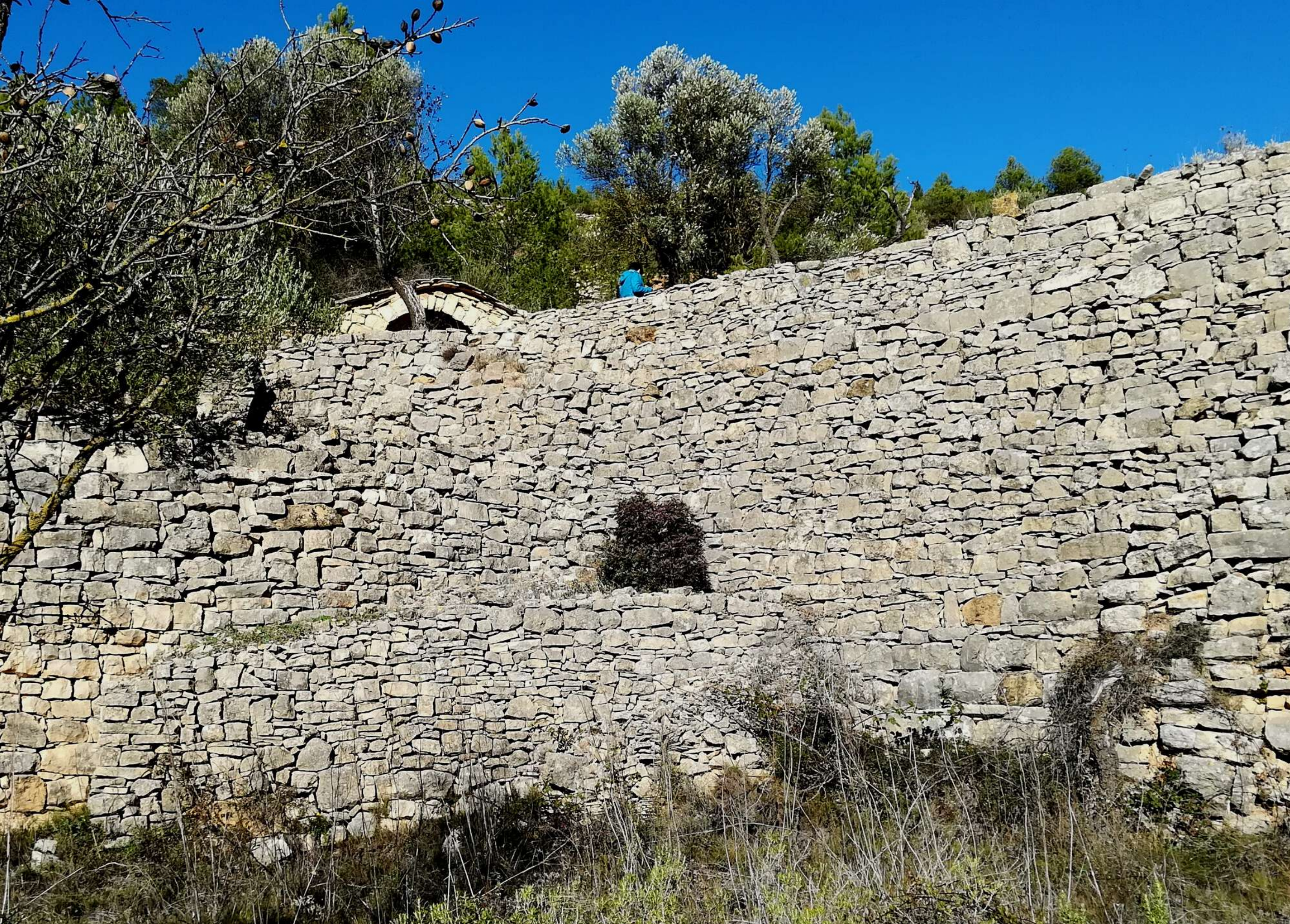
Mur de pedra en sec ubicat al terme municipal de la Fatarella (Terra Alta).
